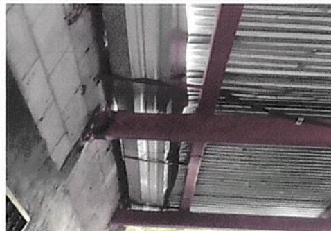
Foto 4: Sustitución de canales y bajadas de agua
