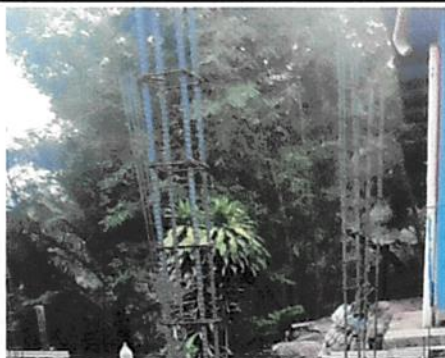
Foto 5: Cambio de Malla muro perimetral
