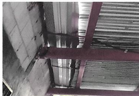
Foto 4: Sustitución de canales y bajadas de agua
