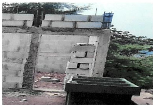
Foto 3: Sustitución de puerta de cocina
