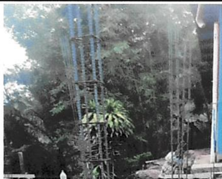
Foto 5: Cambio de Malla muro perimetral
