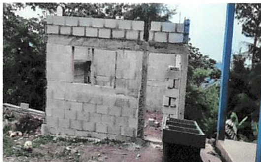
Foto 2: Mejoramiento de ventanas de PVC
