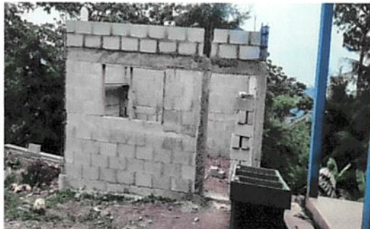
Foto 2: Mejoramiento de ventanas de PVC
