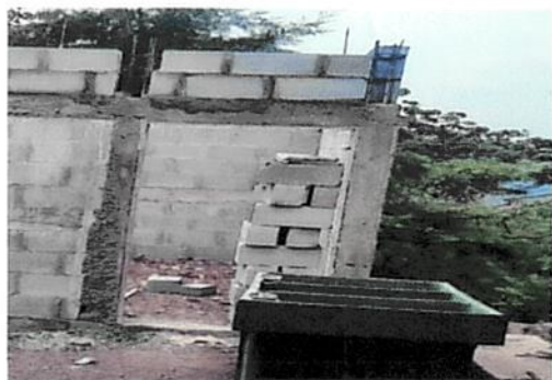
Foto 3: Sustitución de puerta de cocina
